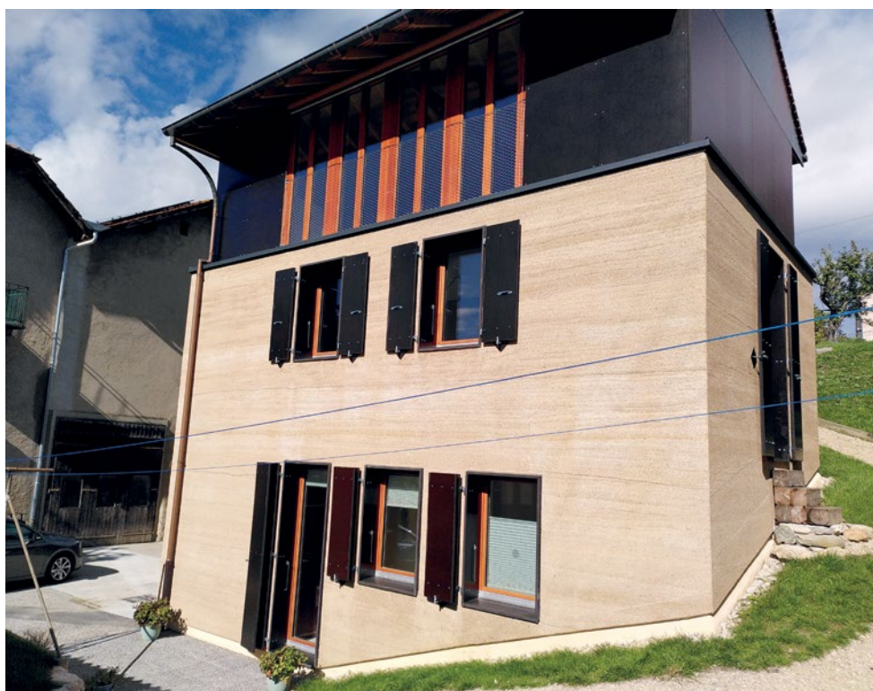
Murs isolants d'Arbio SA en béton de chaux-chanvre brut de décoffrage. DR
