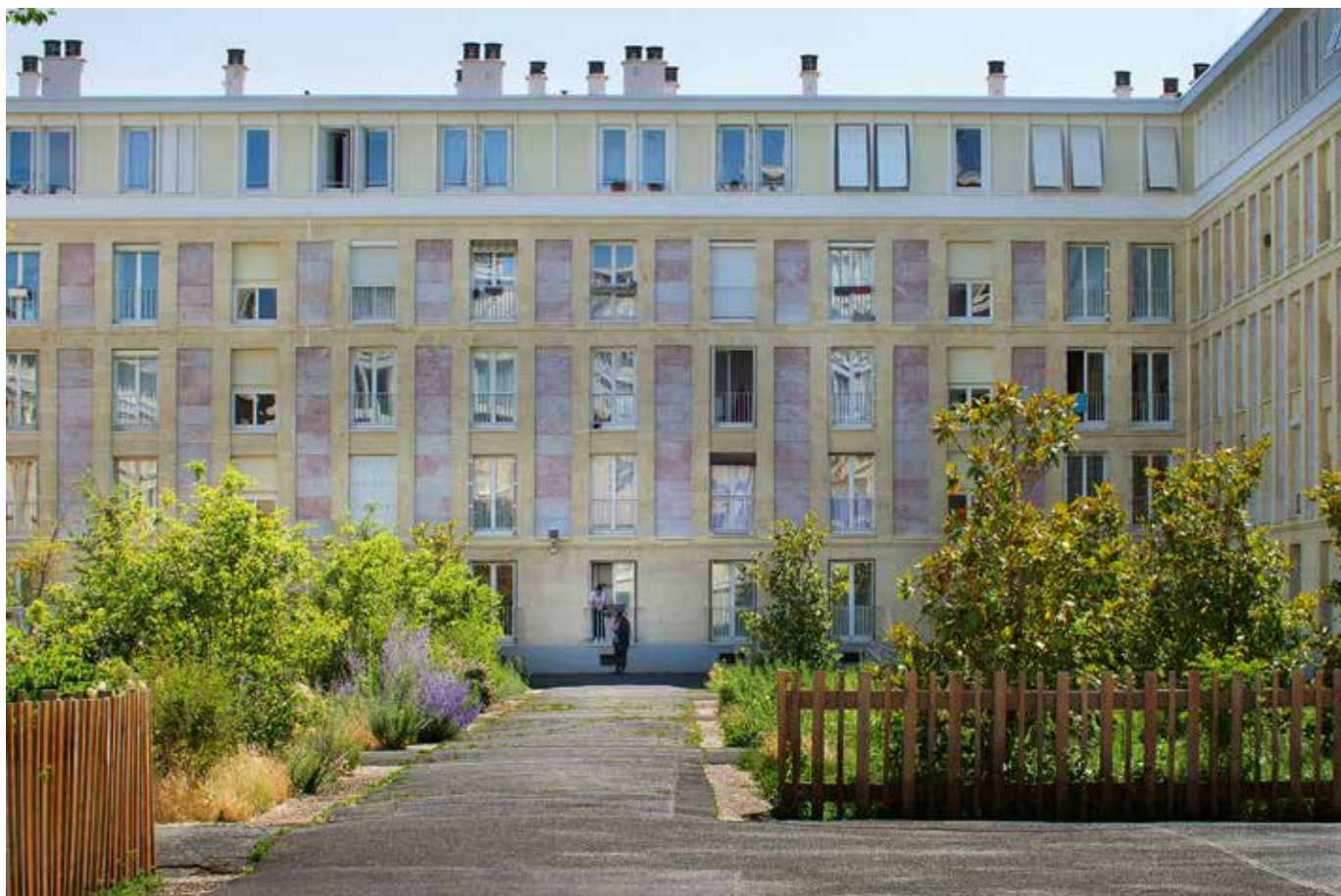
Discussion entre voisins au pied d'un des bâtiments de la résidence Buffalo. Une rencontre inattendue qui témoigne d'une intégration réussie de l'échelle humaine dans un ensemble urbain. Les ouvertures en façade répondent à un paysage intérieur aux aménagements contrastés et créent un séquençage spatial fin allant de l'intime au public. Les espaces intermédiaires ainsi créés ont une forte valeur d'usage. L'homme n'est pas écrasé par l'ensemble bâti et l'habite pleinement : il enjambe les garde-corps, bronze sur la pelouse, discute sur les marches de l'entrée du bâtiment, rencontre ses voisins pour boire une bière le long de la fontaine. Résidence Buffalo, logement collectif (Comptoir National du Logement), Fernand Pouillon, Montrouge, France, 1958.
