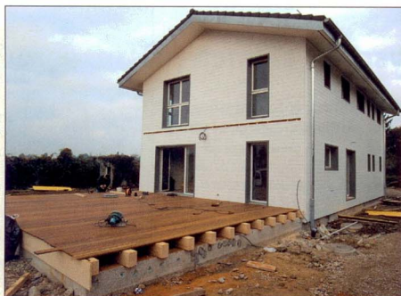
La façade pignon, avec sa terrasse en IP. La maison est entièrement construite en bois et avec des matériaux naturels.
