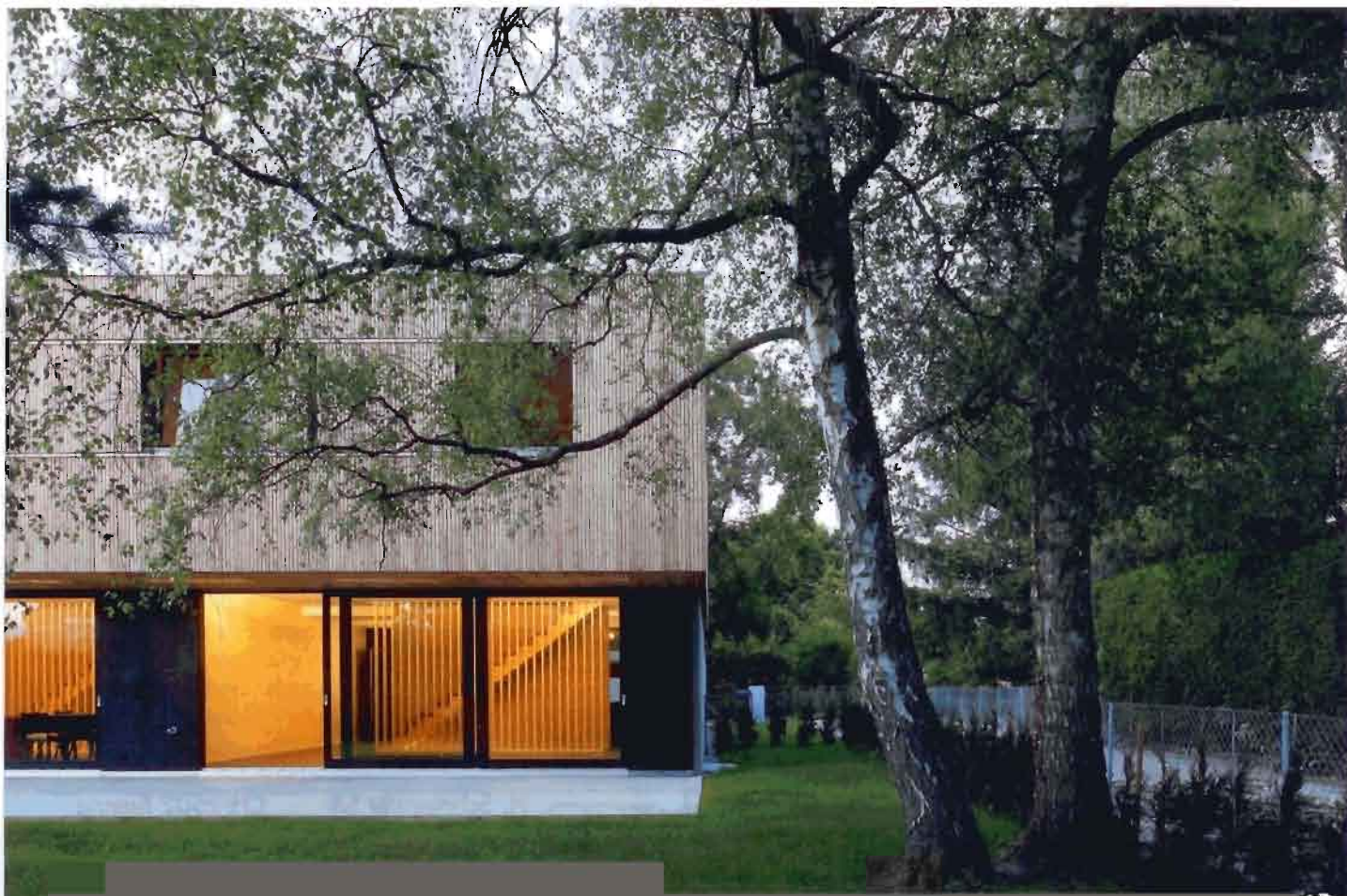
Béton, terre et bois: une harmonie inventée pour trois logements contigus aux standards Minergie Eco. Ils ont trouvé leur place sur une aire paisible des environs genevois.
