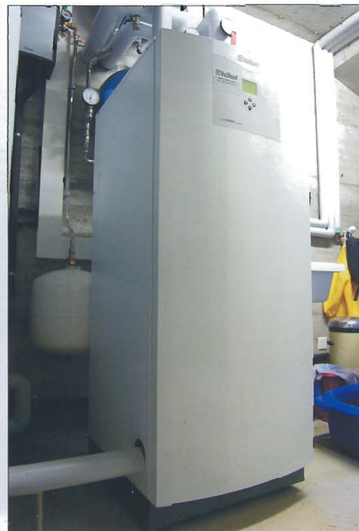
6 m 2 de capteurs solaires assurent l'appoint pour la préparation de l'eau chaude sanitaire dans un boiler de 500 litres.
