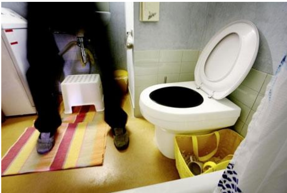
Les toilettes sèches.
