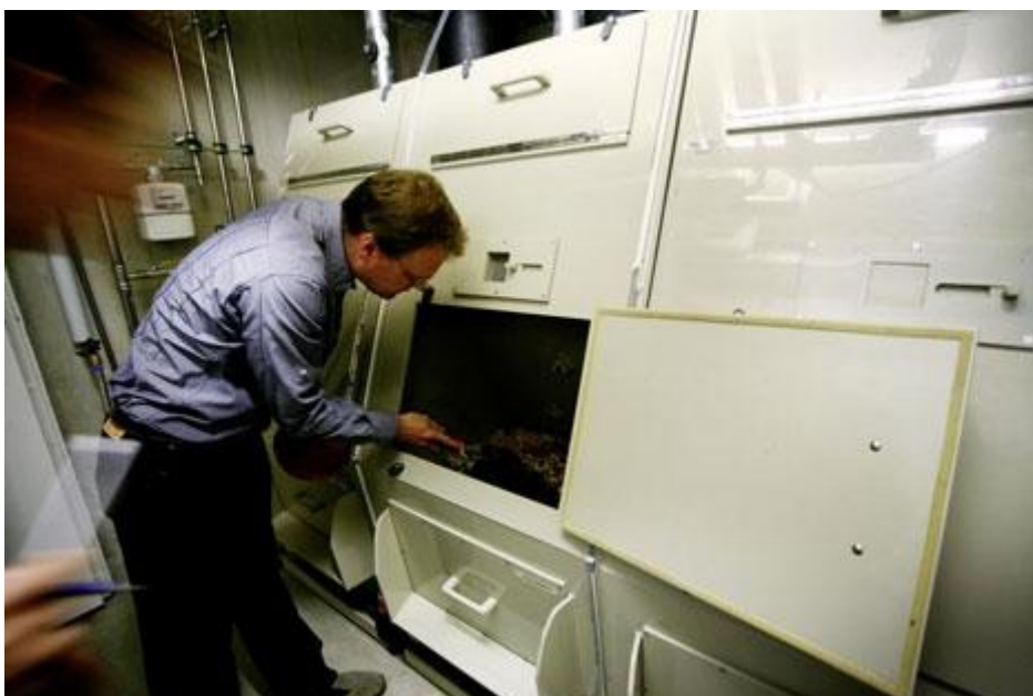
Les composteurs à la cave
