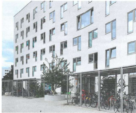
Die eigenwilligen Fensterformate auf der Rückseite bestimmten die Mieter selbst.
