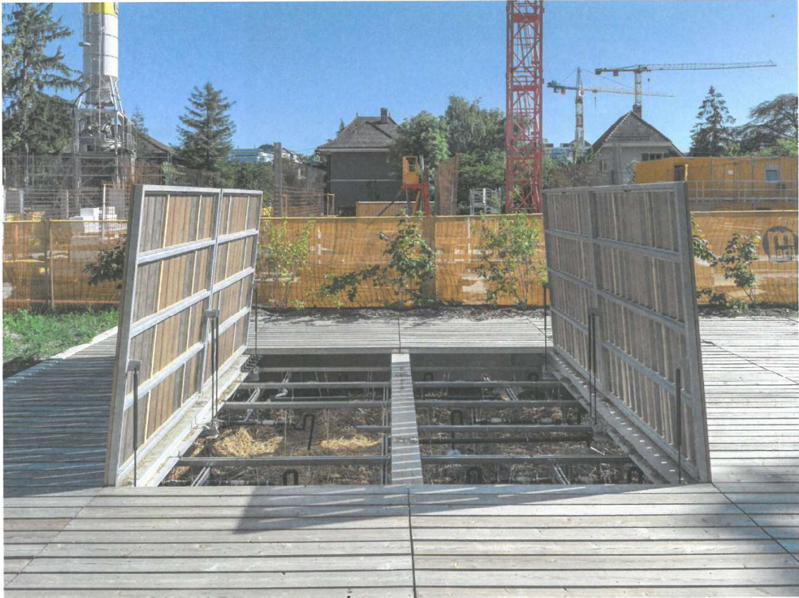
Da gärt was: Unter dem Gartensitzplatz verbirgt sich die Kläranlage, in der Würmer die Exkremente der Bewohner kompostieren.
