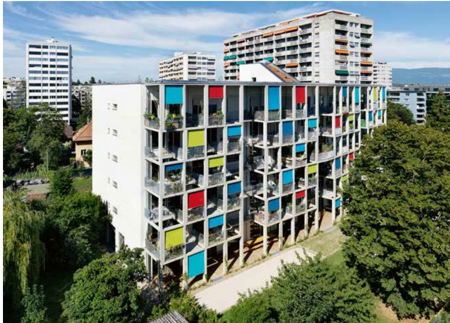
Les livings donnent sur le Sud. Les espaces laissés entre les balcons assurent un supplément de luminosité aux appartements. Annik Wetter/DR
