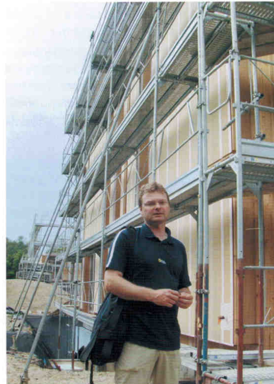
Ralph Thielen, pilote du projet, devant l'immeuble en construction, début juillet 2009. © Vincent Borcard
