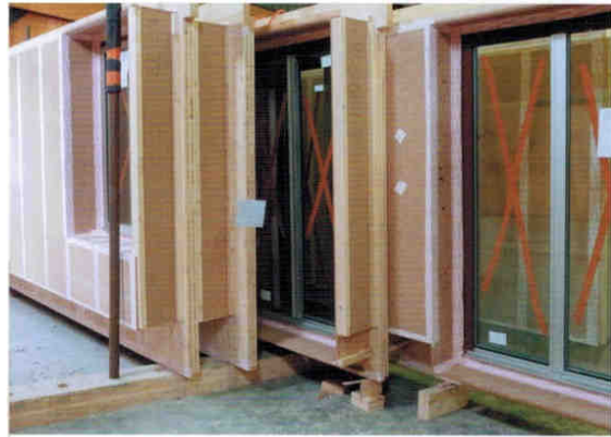
Les coffres en bois, éléments porteurs et d'isolation thermique, sont livrés préfabriqués. © Equilibre
