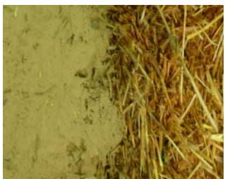
Construction d'une maison en paille, Morrens Minergie, 2008
