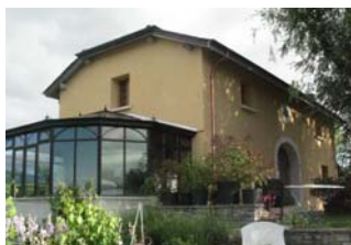
Rénovation d'une villa, Satigny Minergie, 2008
