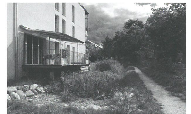
VUE SUR LA PHYTO-ÉPURATION | BLICK AUF DIE PHYTO-KLÄRUNG
