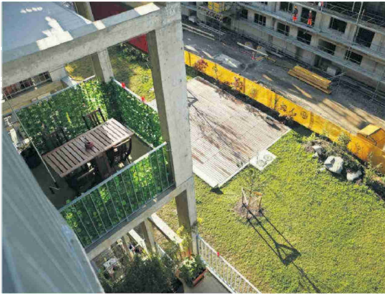
L'immeuble traite lui-même ses eaux usées. La station d'épuration se situe sous la plate-forme en bois, et ressemble à des tas de paille. Le système nécessite des w-c à deux orifices. LAURENT GUIRAUD
