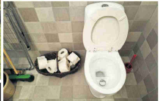
L'immeuble traite lui-même ses eaux usées. La station d'épuration se situe sous la plate-forme en bois, et ressemble à des tas de paille. Le système nécessite des w-c à deux orifices. LAURENT GUIRAUD
