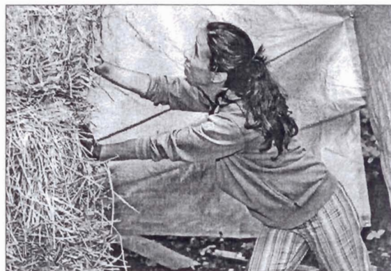
Une petite équipe de bâtisseurs est en train de monter les murs, botte sur botte. Celles-ci seront tassées, puis enduites de terre.
